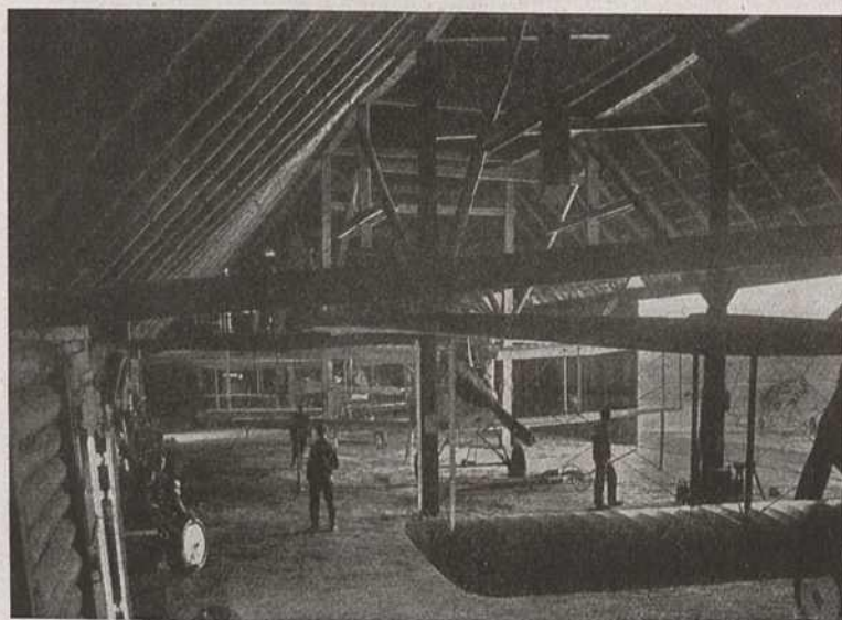
Als Flugzeughalle benutzte Scheune
