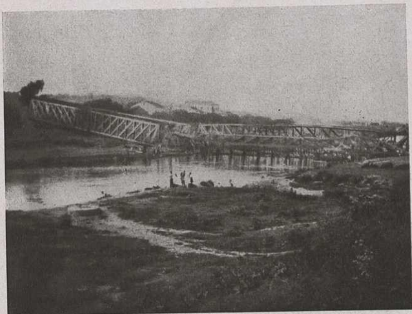
Przemysl. Die, von den Russen beim Abzug gesprengte Eisenbahnbrücke (3. Juni 1915)
