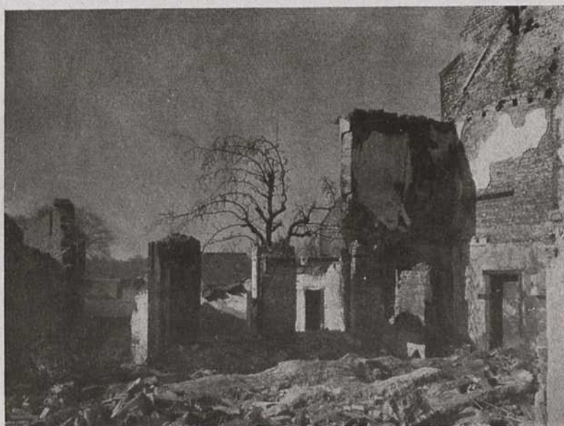
Zerstörte Teile Le Nouvion's
