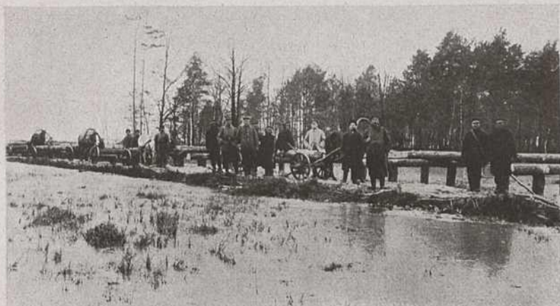
Bau der Leopoldbrücke bei Olfchany
