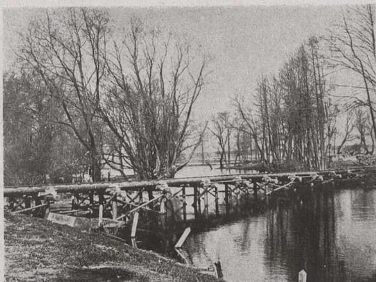
Bau der feldbahnbrücke bei Þorietshje (Frühjahr 1916)
