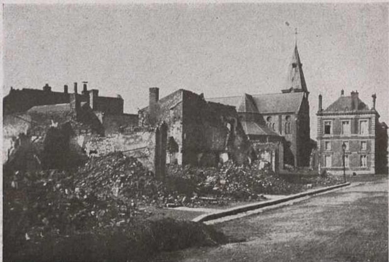
Zerstörte Häuser in Le Nouvion
