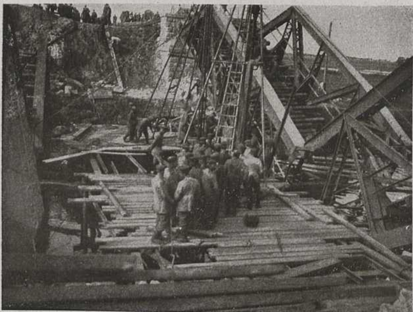
Eisenbahntruppen beim Bau einer Notbrücke über den Dnjepr-Bug-Kanal bei Horodec
