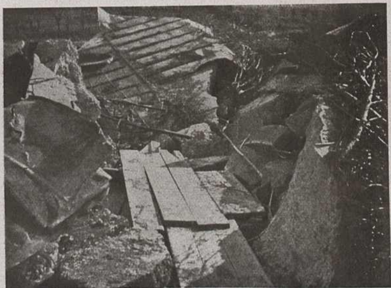
Zerhoffener Panzerturm im fort XI bei Przemyśl
