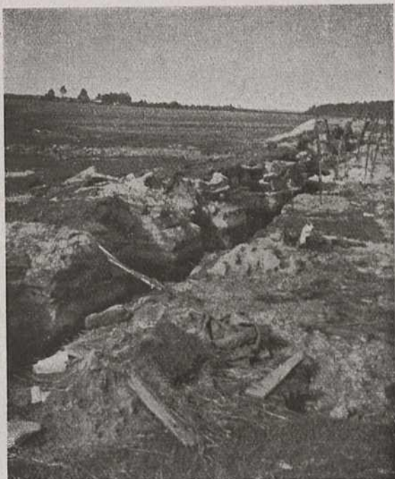
Russischer Schützengraben vor dem Dnjepr-Bug-Kanal bei Nowofielki
