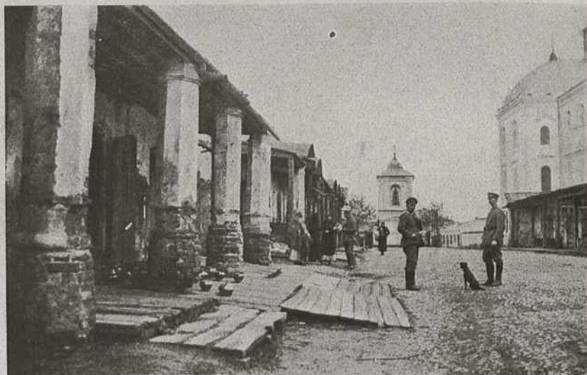
Die „Gewölbe“ in Pinsk
