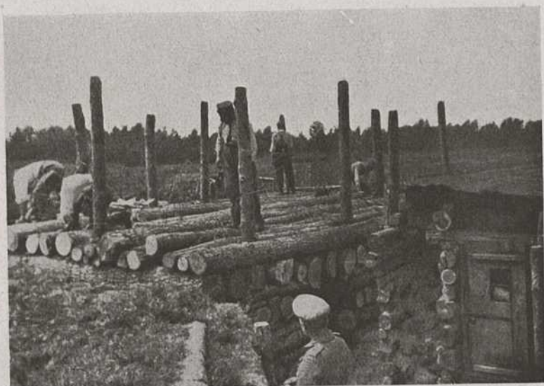
Bau eines Kampfunterstandes
