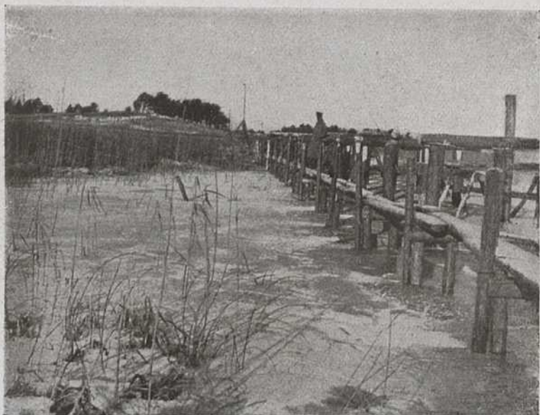
Brückenbau im Sumpfgebiet bei Newel (Winter 1916/17)
