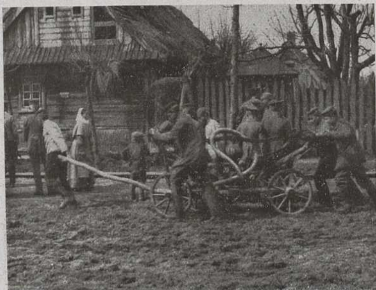
Nach gelöschtem Dachbrand der Apotheke zu Iwanowo (April 1917)
