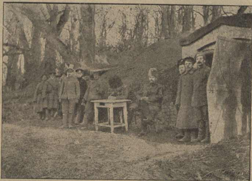
Наши траншеи и землянки на галиційскомъ фронтѣ.
